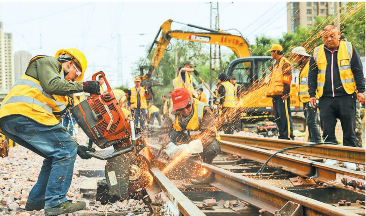
5月7日，中国铁路郑州局集团有限公司郑州桥工段施工人员正在切割旧轨。近日，该工段集中更新道岔，采用新型机械，强化现场安全卡控，对线路、桥梁、道岔及站场设备进行集中综合整治，按计划推进施工任务，全面提升动车组及旅客列车走行径路的质量。
