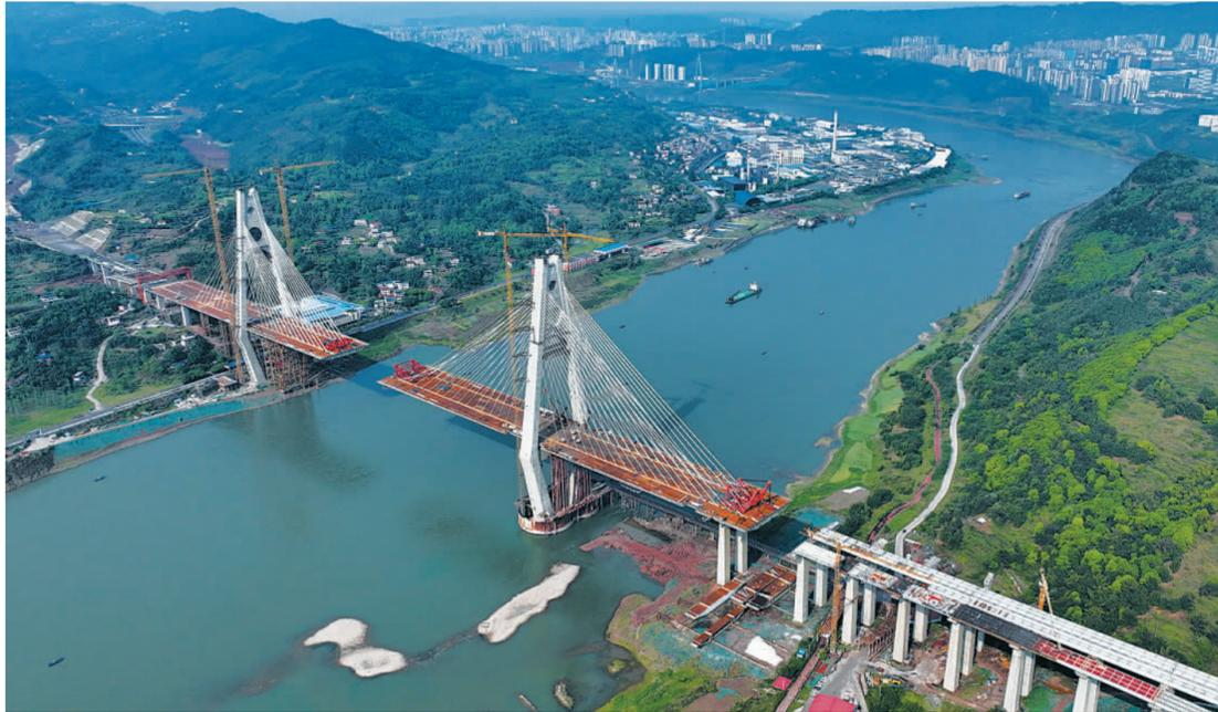
4月2日，在四川省宜宾临港铁路两用长江大桥项目现场，建设者正加紧施工。该桥是新建川南城际铁路自贡至宜宾线的重点控制性工程，建成后将成为国内首座高铁与公路双层布置的斜拉桥，世界最大宽度的公铁两用斜拉桥。兰 锋摄(中经视觉)
