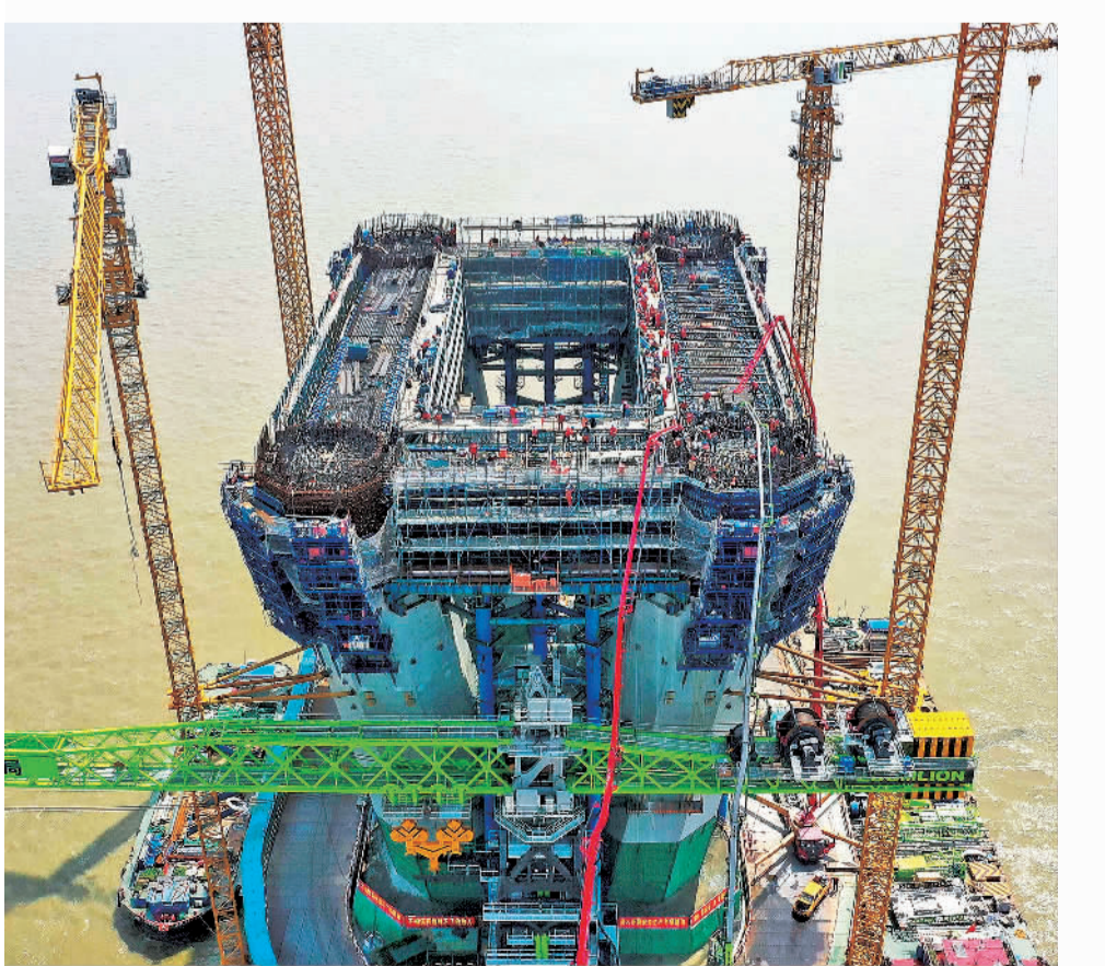
4月4日,中交二航局工人对常泰长江大桥北主塔下横梁进行浇筑施工。当日,在建世界最大跨度公铁两用斜拉桥——常泰长江大桥北主塔下横梁首个“L”型区域浇筑完成。汤德宏摄(中经视觉)
