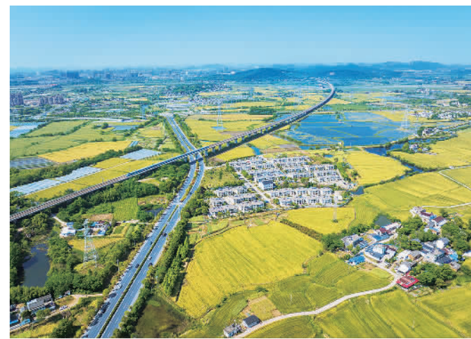
安徽马鞍山当涂县大力实施“四好农村路”民生工程,打通公路、铁路等综合立体交通网络,推进城乡一体化发展。 张明伟摄(中经视觉)
