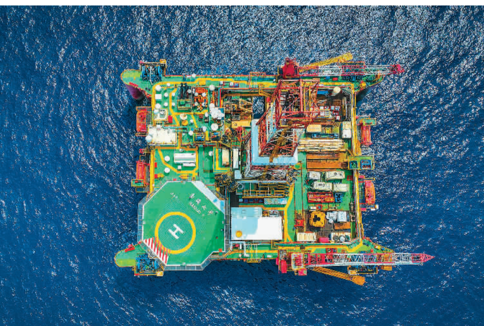
5月10日,在海南莺歌海海域钻井平台,工人对我国首套国产化深水水下采油树设备进行安装。该水下生产系统将用于开发东方1—1气田乐东平台周边的气藏,单井每年可产天然气约2亿立方米。
