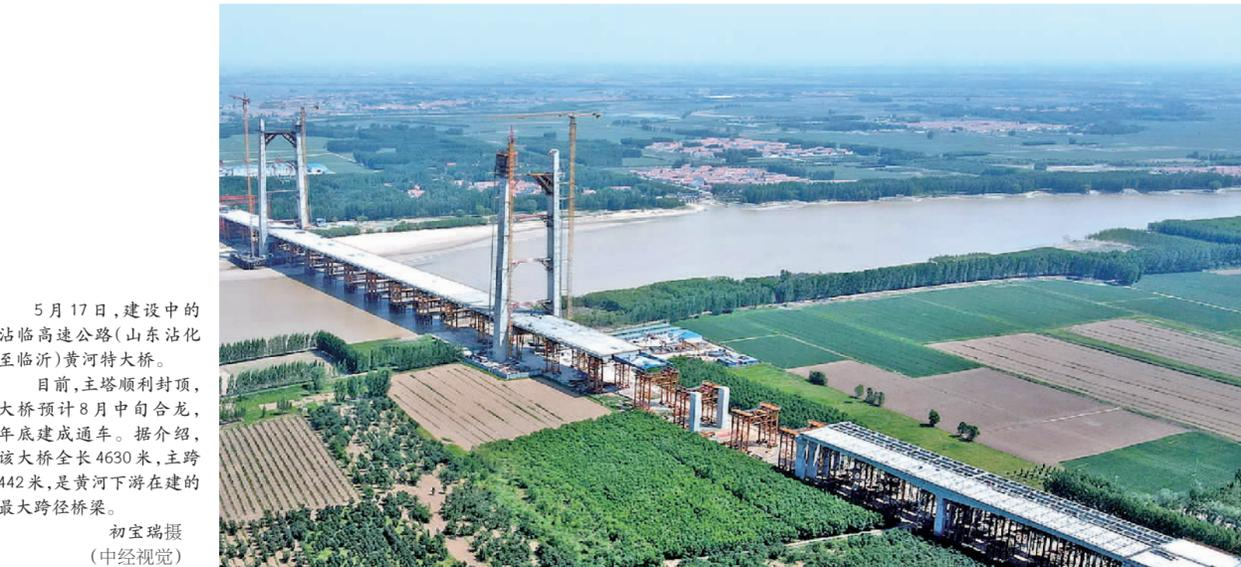
5月17日,建设中的沾临高速公路(山东沾化至临沂)黄河特大桥。目前,主塔顺利封顶,大桥预计8月中旬合龙,年底建成通车。据介绍,该大桥全长4630米,主跨442米,是黄河下游在建的最大跨径桥梁。初宝瑞摄(中经视觉)
