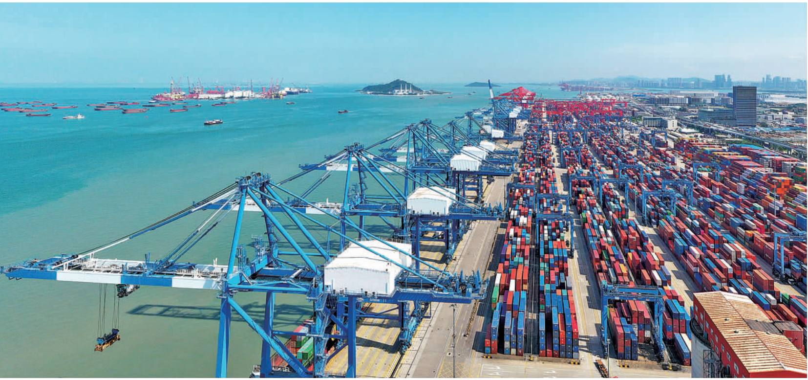
5月17日，繁忙的深圳妈湾智慧港。该港是粤港澳大湾区建设的首个5G绿色低碳智慧港口，依托人工智能、5G应用等技术，将原海星码头4个泊位升级为自动化集装箱港区，形成年吞吐量约250万标箱的现代化智慧港口。王美燕摄（中经视觉）
