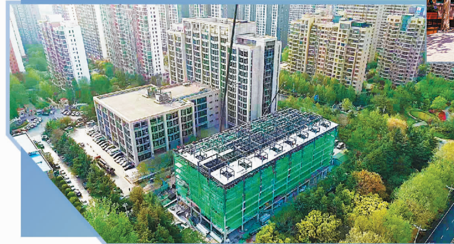
青岛胶州市行政服务中心西楼立体停车场建设现场。
