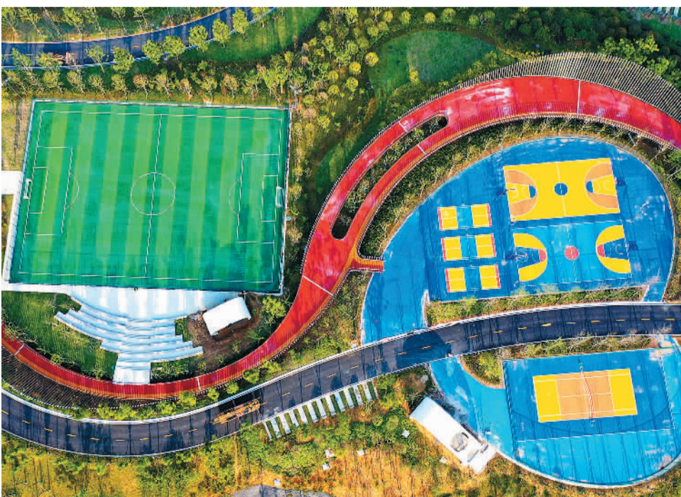
近日，在四川省南充市蓬安县体育中心的施工现场，工程正如火如荼地进行着。今年以来，蓬安县着力加大重点民生工程建设力度，确保项目如期完成。
