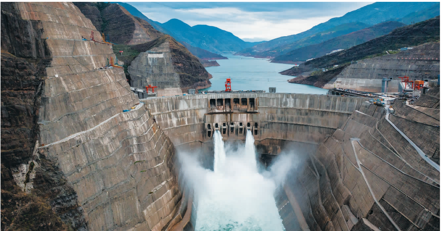
5月20日,位于白鹤滩水电站右岸地下厂房内的9号机组总装工作完成,标志着白鹤滩水电站机组总装工作全部完成,进入全面投产冲刺阶段。
