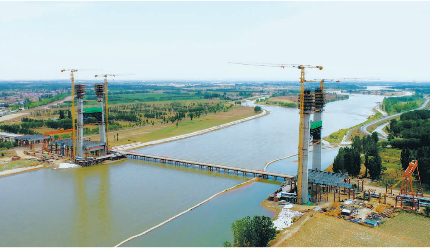
5月22日,宁夏中卫下河沿黄河公路大桥建设现场。该大桥是宁夏规划建设第20座黄河公路大桥,建成后 will 改善区域交通出行条件,对当地构建旅游中心城市以及促进区域经济社会发展具有重大意义。 袁宏彦摄(中经视觉)
