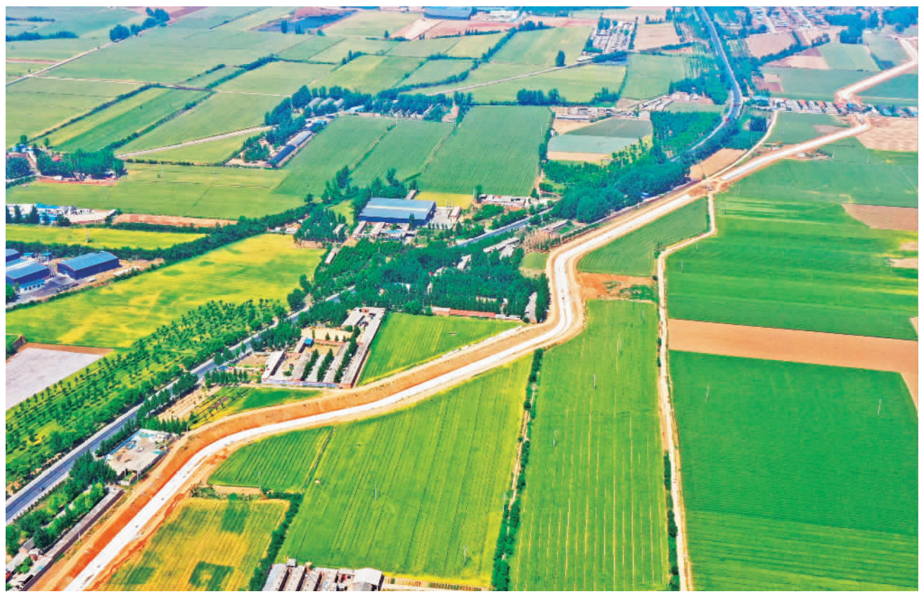
5月20日,俯看黄河小浪底北岸灌区工程河南孟州西治至禹寺段。该工程总投资32.32亿元,设计年引水量2.39亿立方米,建成后可为51.7万亩耕地提供农业灌溉用水,同时可为20万亩耕地提供补水,对构建黄河北岸清水走廊、改善区域生态环境、增加粮食生产能力具有重要意义。白永平摄(中经视觉)
