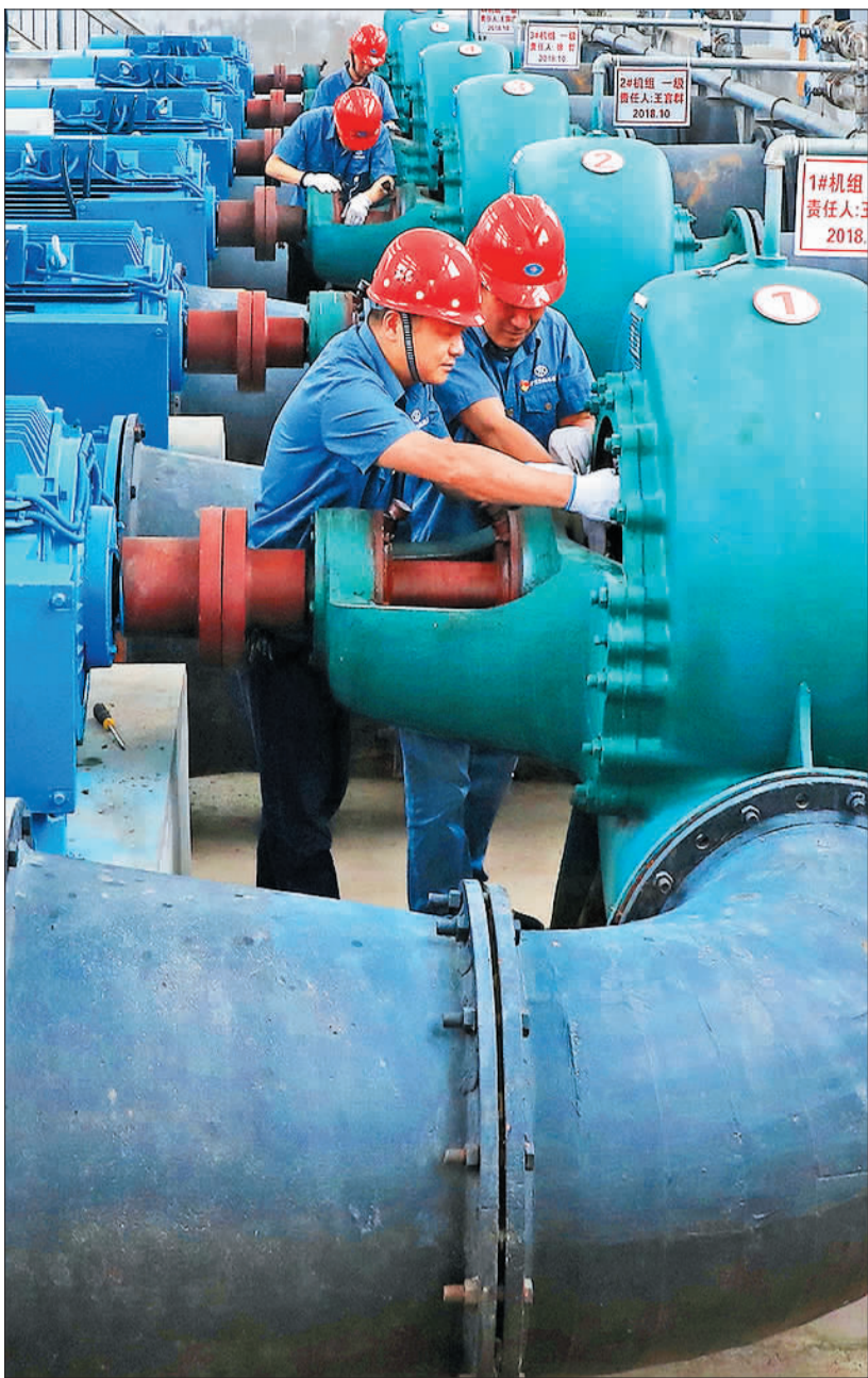
▲安徽省庐江县庐城镇城南电灌二站,员工正在对排涝机泵设备进行检修,保障设备安全运行。 柳晓华摄(中经视觉)
