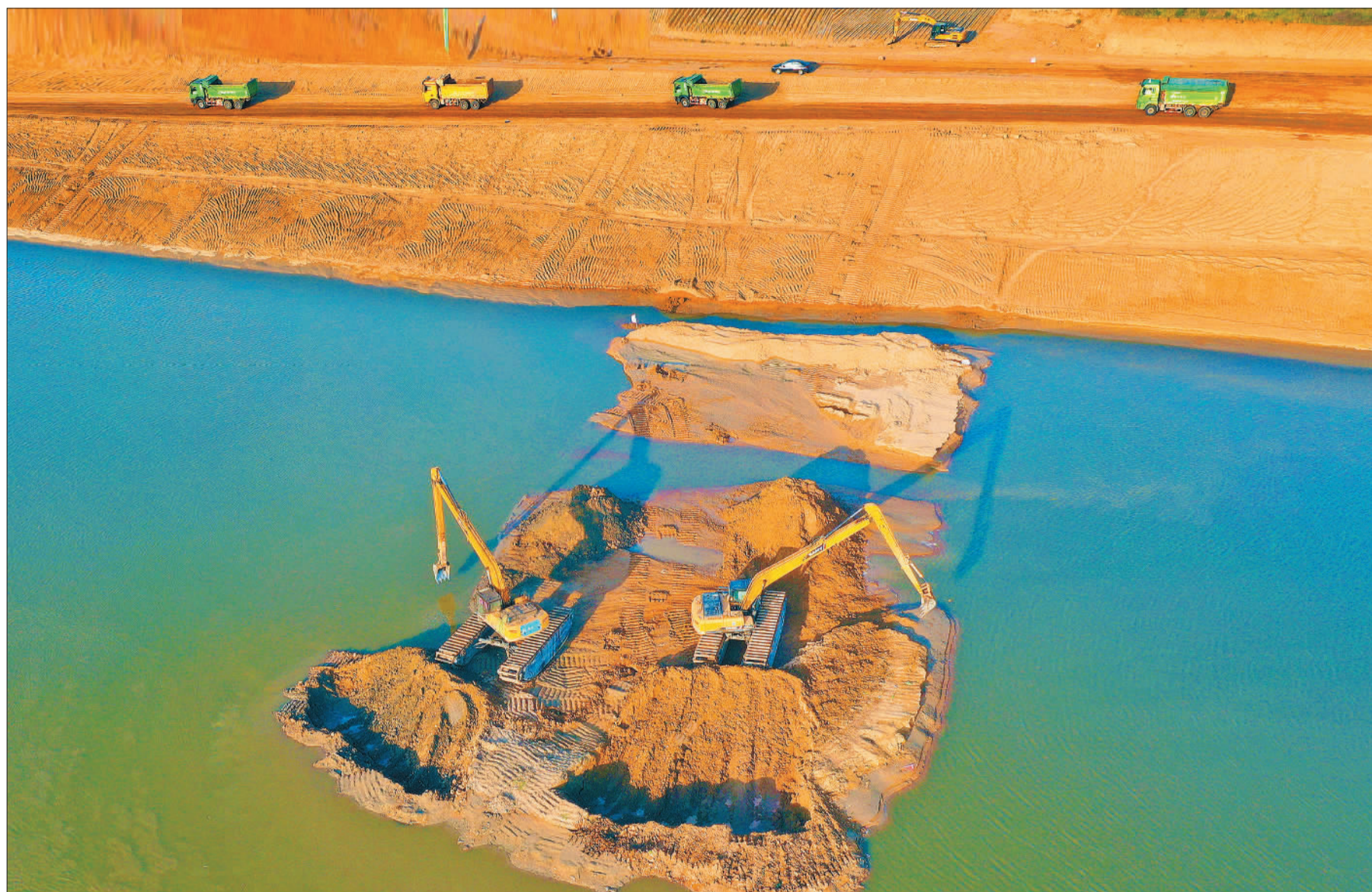
▲河南省尉氏县贾鲁河治理工程庄头镇后曹段,大型工程机械在疏浚河道。投资14.1亿元的标志性工程尉氏段将加固堤防53.52公里,项目完成后大大提高当地防汛能力。 李新义摄(中经视觉)
