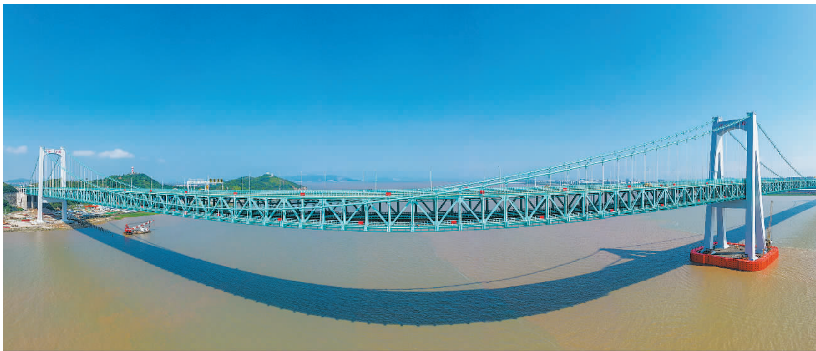
5月27日,由中交二航局承建的世界首座三塔四跨双层钢桁梁悬索桥——温州瓯江北口大桥建成通车,标志着连接浙闽粤三省的沿海大动脉——甬莞高速全线正式通车。大桥起于浙江省乐清市黄华镇,止于灵昆岛,全长7.913公里。 杜才良摄(中经视觉)
