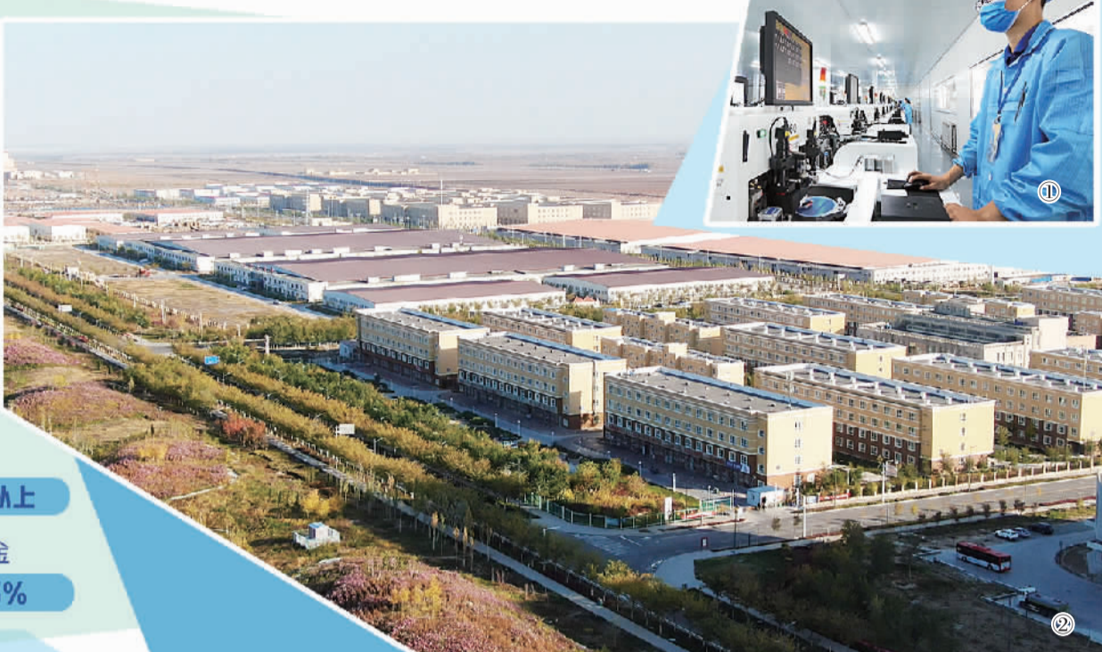
图① 博乐晖力普电子科技有限公司的芯片集成智能制造车间内， 员工在加工电子发光芯片。
