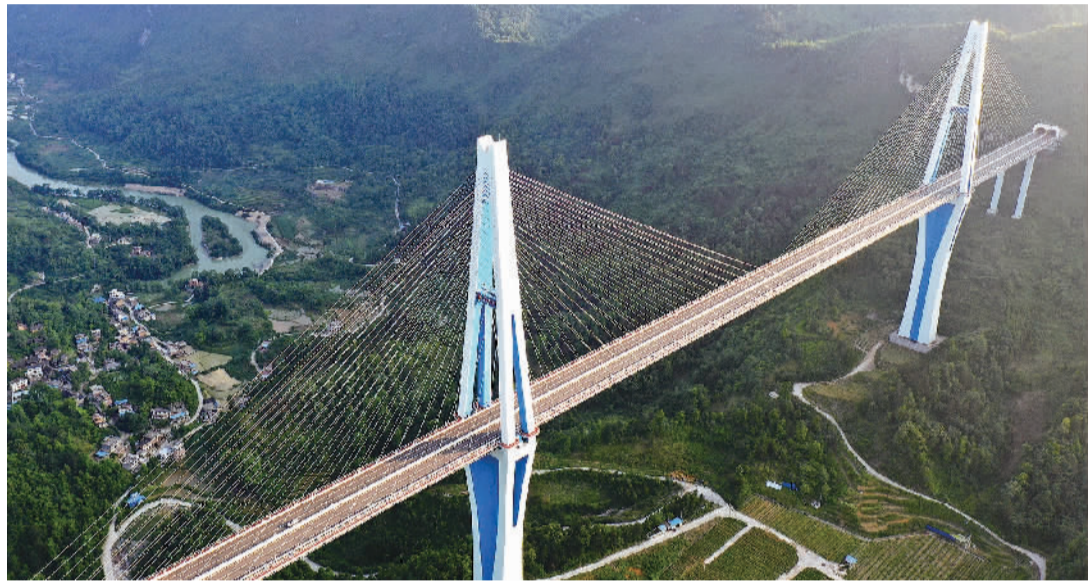
近日，位于贵州省余庆至安龙高速公路平塘至罗甸段的平塘特大桥巍峨耸立于崇山峻岭之中，与河流、村庄等交相辉映。平塘特大桥横跨槽渡河峡谷，为贵州山区最大跨径的三塔斜拉桥，桥塔采用钻石形设计，主塔高达332米，创下了“最高混凝土桥塔”的世界纪录。胡攀学摄（中经视觉）
