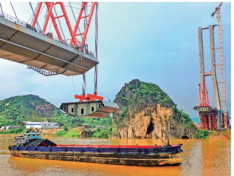
近日,位于广西横州市百合镇的南玉铁路百合郁江特大桥项目建设现场,中铁九桥工程有限公司建设者在钢梁进行吊装作业。据了解,南宁至玉林铁路百合郁江特大桥为南玉铁路重点控制性工程,主桥设东西两座主塔,塔高146米,桥长612米,是目前世界最大跨度的双线无砟轨道桥。熊红梅摄(中经视觉)
