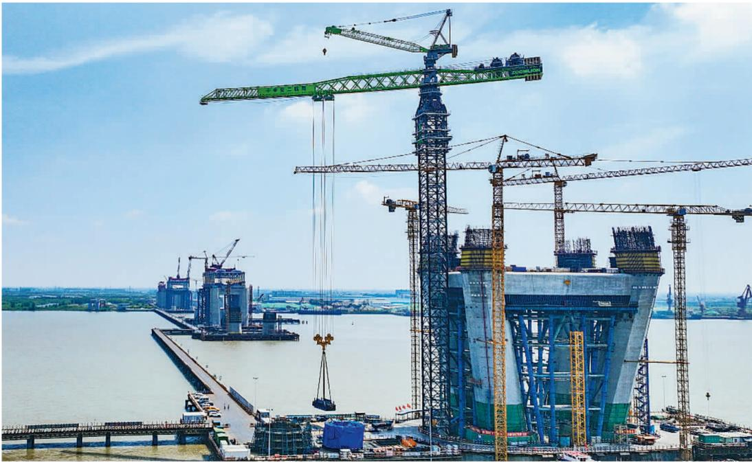
6月7日,江苏泰州市,全球首台超万吨米级上回转超大型塔机在中交二航局承建的常泰长江大桥投入使用。该塔机最大起重重量达450吨,最大起升高度400米,相当于可一起吊300辆小轿车至130层楼的高度,彰显我国大型装备制造实力。赵振宇摄(中经视觉)
