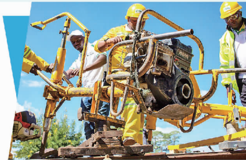
图为莫桑比克工人在进行铁路轨道施工。
