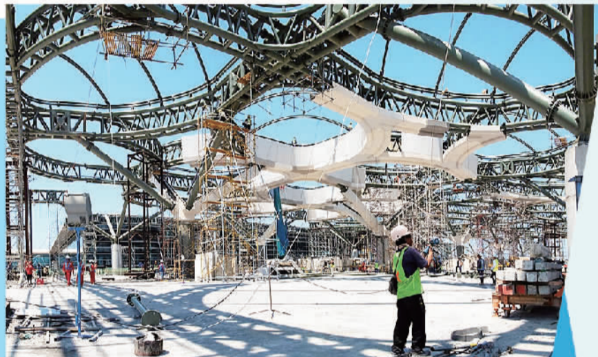
图为建设中的印尼日惹国际机场。
