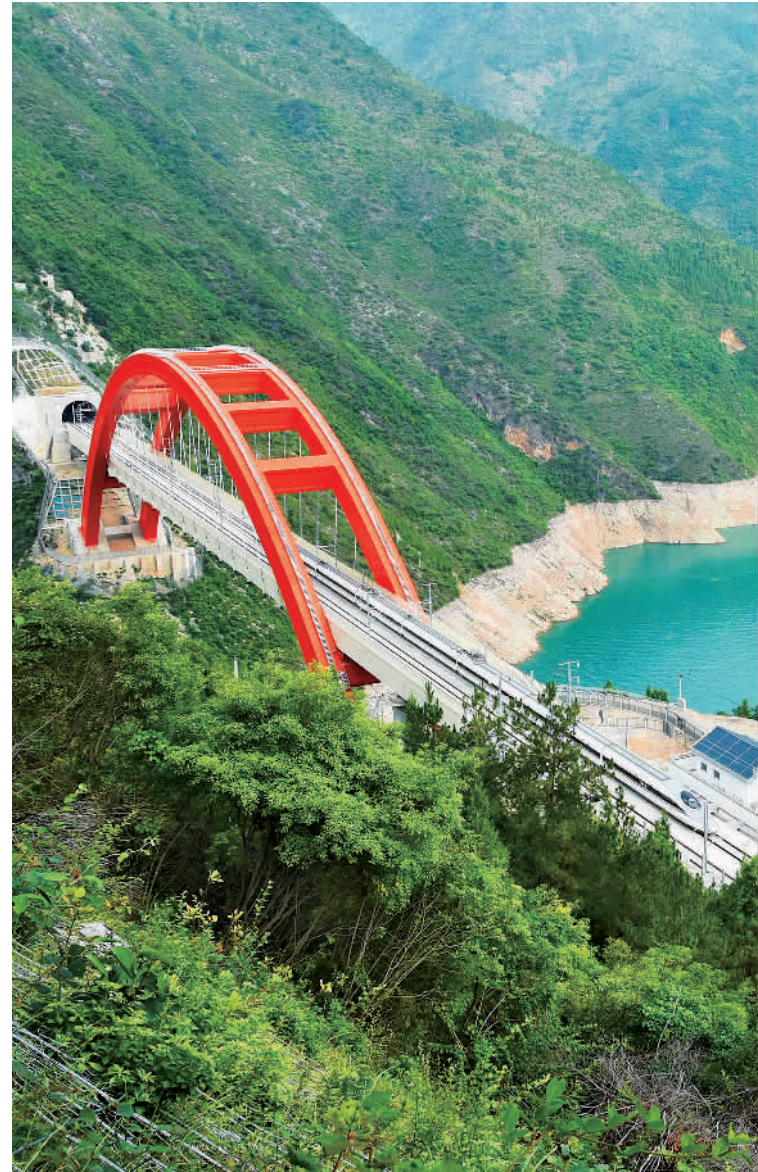
6月18日,一列测试动车行驶在郑渝高铁重庆巫山段大宁河特大桥上。郑渝高铁全线于6月20日贯通运营。同时,6月20日零时起,全国铁路实行新的列车运行图,客货运输提质增效,城市间旅行时间再压缩。王忠虎摄(中经视觉)
