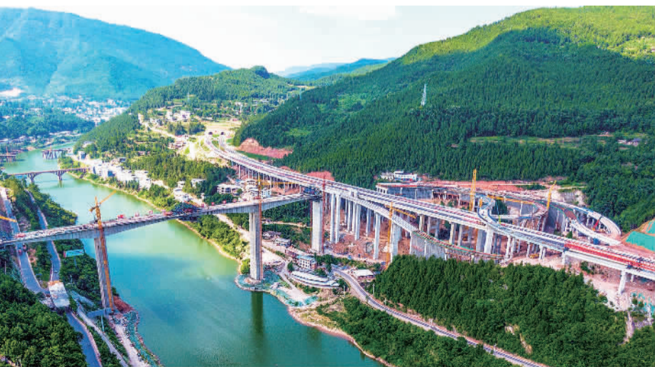
6月15日，四川省通江县、镇(陕西镇巴县)广(四川广安市)高速通江东互通顺利合龙。该公路北连陕西、南接重庆，建成后将成为通江县北向出川的大通道。程 聪摄(中经视觉)
