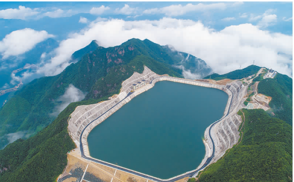
6月30日，位于浙江省湖州市安吉县境内的长龙山抽水蓄能电站全部机组正式投产发电。该项目总投资106.83亿元，总装机规模210万千瓦。该电站主要承担为整个华东电网调峰、填谷的功能，每年可生产清洁电能24.35亿千瓦时，节约标准煤约21万吨，减少二氧化碳排放约42万吨。
