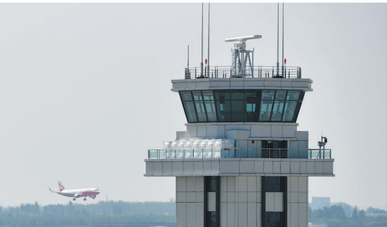
7月7日拍摄的郑州新郑国际机场三期扩建工程飞行区塔台。
