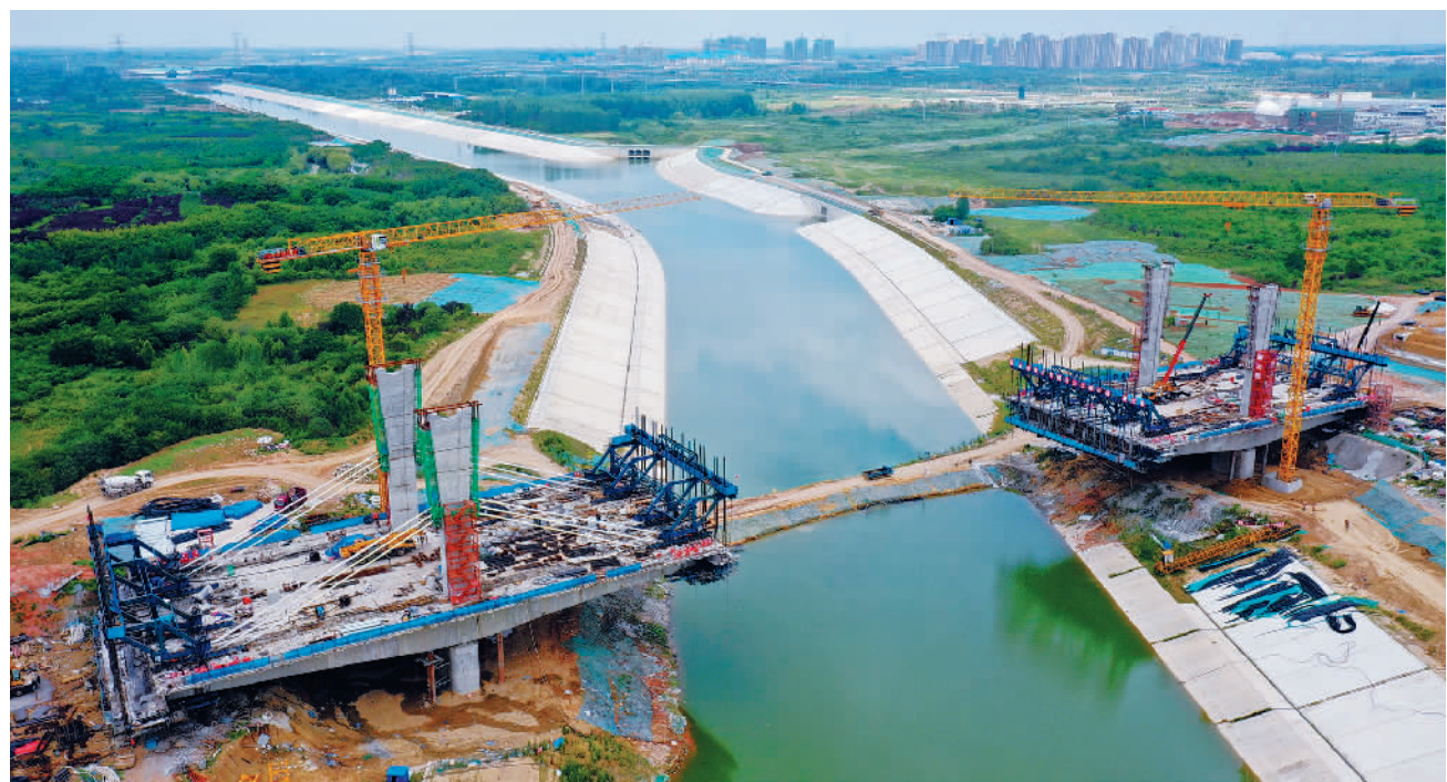
7月7日,建设者在引江济淮工程安徽省合肥市蜀山区段施工。引江济淮工程沟通长江、淮河两大水系,是跨流域、跨省的重大战略性水资源配置和综合利用工程,供水范围涉及安徽、河南两省55县(市、区),有望今年9月底试通水。 陈三摄(中经视觉)
