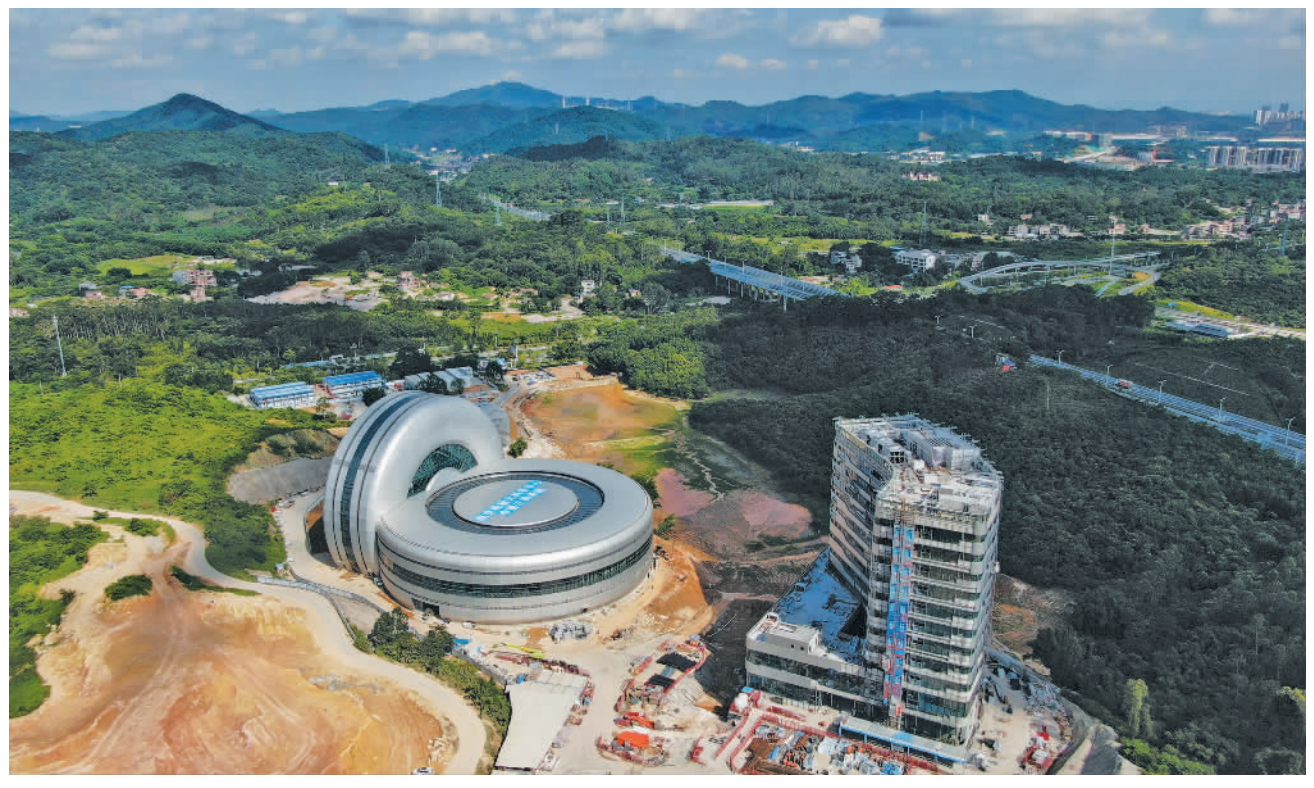
这是位于广州市黄埔区的航空轮胎大科学中心(7月14日摄),目前主体建筑已完成施工。该项目依托中科院长春应化所、广东粤港澳大湾区黄埔材料研究院的科研优势,以航空轮胎动力学大科学装置为核心,建设与之配套的航空轮胎模核科技中心和航空轮胎制造试验基地。新华社记者 邓华摄
