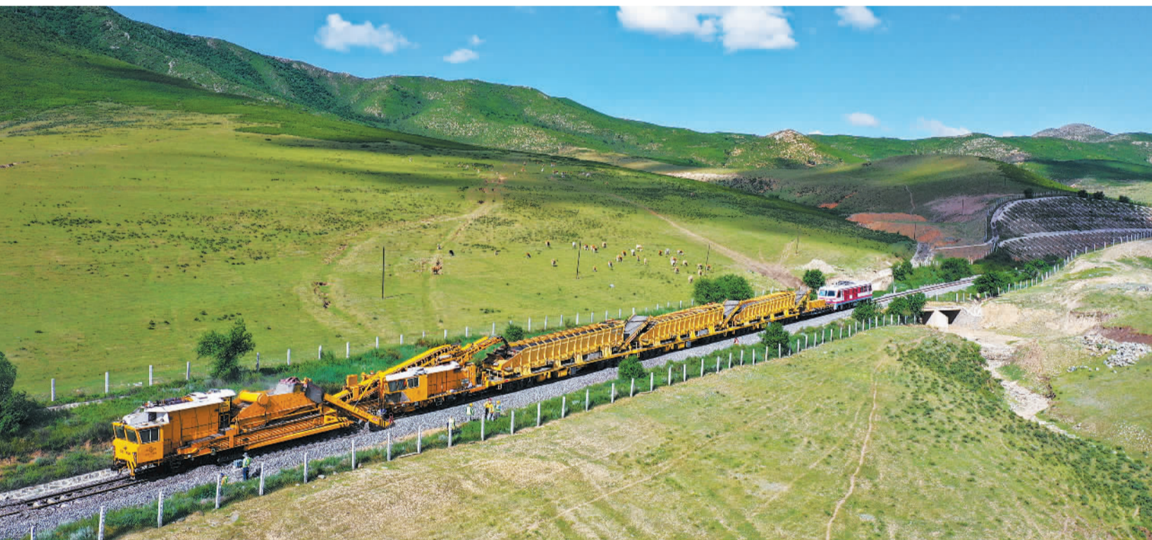
7月14日,位于内蒙古赤峰市的赤(峰)大(板)白(音华)铁路上,一辆工程车正在清筛道床上的污土。这是该铁路线路首次采用机械化清筛作业,进一步提高了作业质量,节约了人工成本,缩短了作业工期,保障迎峰度夏期间电煤运输安全。
