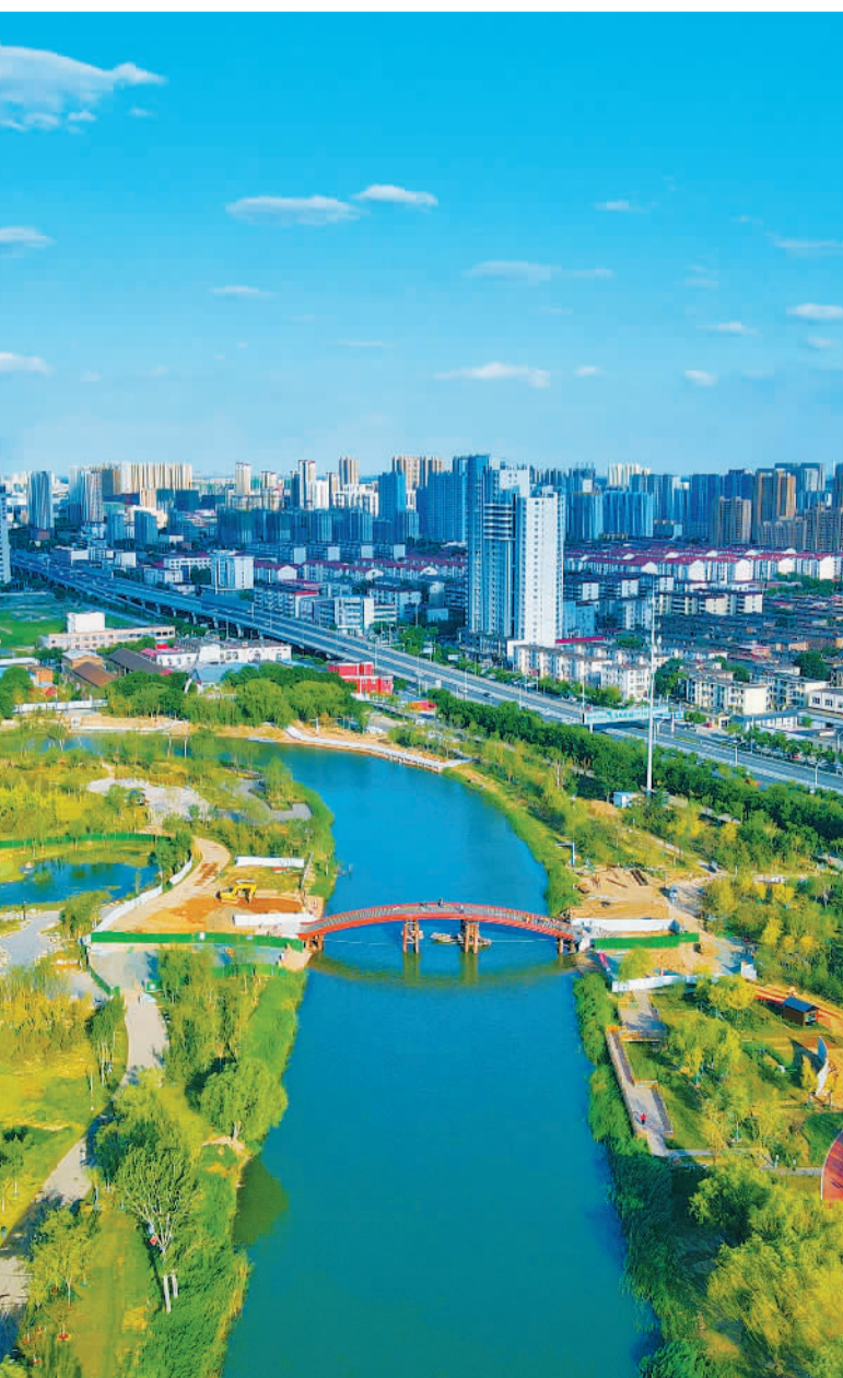
7月21日,俯瞰建设中的京杭大运河生态廊道。由中铁二十二局建设的京杭大运河沧州段代家园码头完成铺装,标志着沧州段生态廊道的码头全部建成,为京杭大运河沧州城区段恢复通航奠定基础。 翟杉杉摄(中经视觉)
