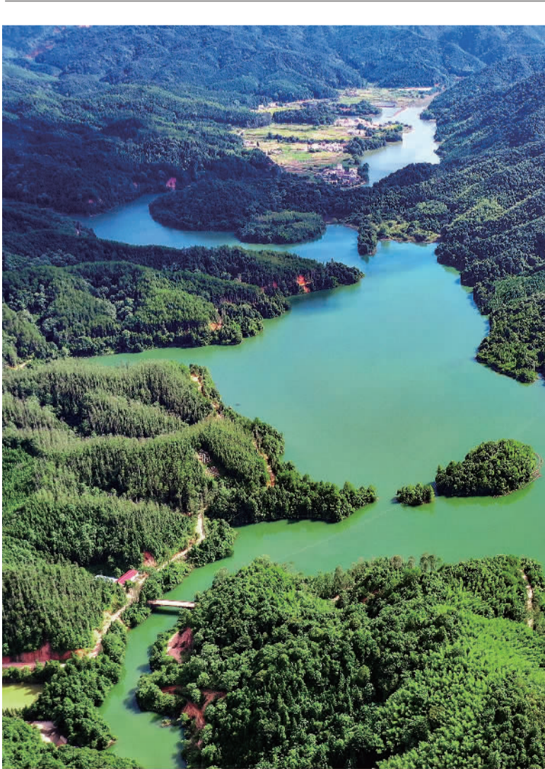
7月28日，位于江西省全南县金龙镇的龙兴水库风景如画。近年来，当地积极推行河(库)长制，常态化开展水系保洁、水质监测，提升水质量，形成了天蓝、地绿、水清、景美的生态环境。 李凡拍摄(中经视觉)
