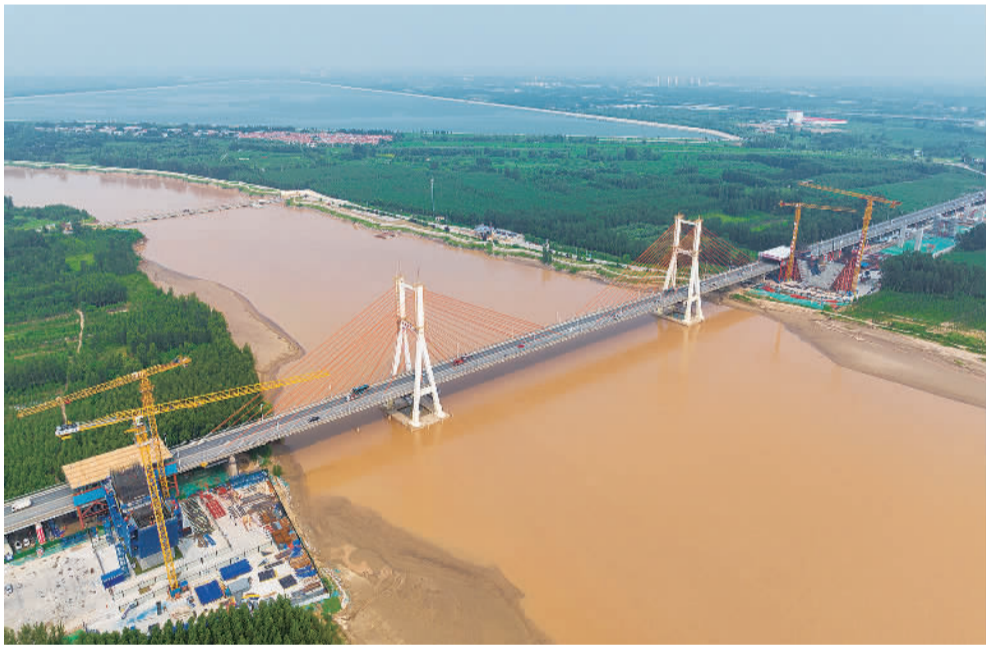
8月2日，山东济南黄河公路大桥扩建工程正加紧施工。该大桥扩建工程全长7.748公里，采用一级公路兼城市快速路建设，设计时速80公里。建成后将有效改善济南市区与黄河北部地区的交通出行条件，对济南“携河发展”战略的实施起到促进作用。徐舟摄（中经视觉）
