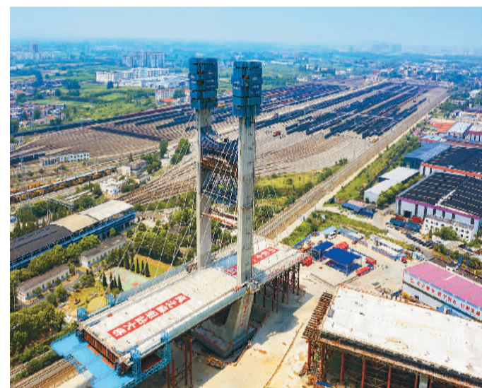
8月3日,由中铁十一局承建的襄北编组站大桥T3主墩转体完成,标志着世界首座齿轮齿轨式转体斜拉桥顺利转体,进入钢一混组合梁悬拼阶段。襄北编组站大桥位于湖北襄阳境内,主桥长920米,宽37.5米,跨越32股铁路线,最大转体重量3.2万吨,大桥顺利转体开创了齿轮齿轨转体斜拉桥施工的先河,为后续国内同类型城市轨道交通项目设计、施工积累了宝贵经验。
