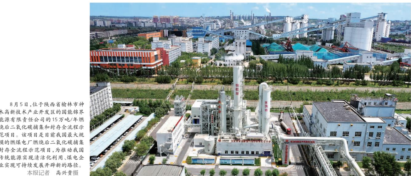
8月5日,位于陕西省榆林市神木高新技术产业开发区的国能锦界能源有限责任公司的15万吨/年燃烧后二氧化碳捕集和封存全流程示范项目。该项目是目前我国最大规模的燃煤电厂燃烧后二氧化碳捕集封存全流程示范项目,为推动我国传统能源实现清洁化利用、煤电企业实现可持续发展开辟新的路径。
