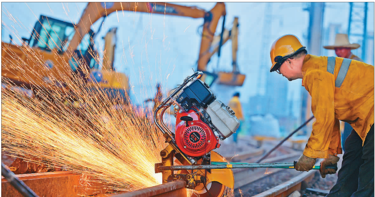
▼中国铁路郑州局集团有限公司铁路职工在道岔升级改造施工现场切割轨料,确保工程进度。王玮摄(中经视觉)
