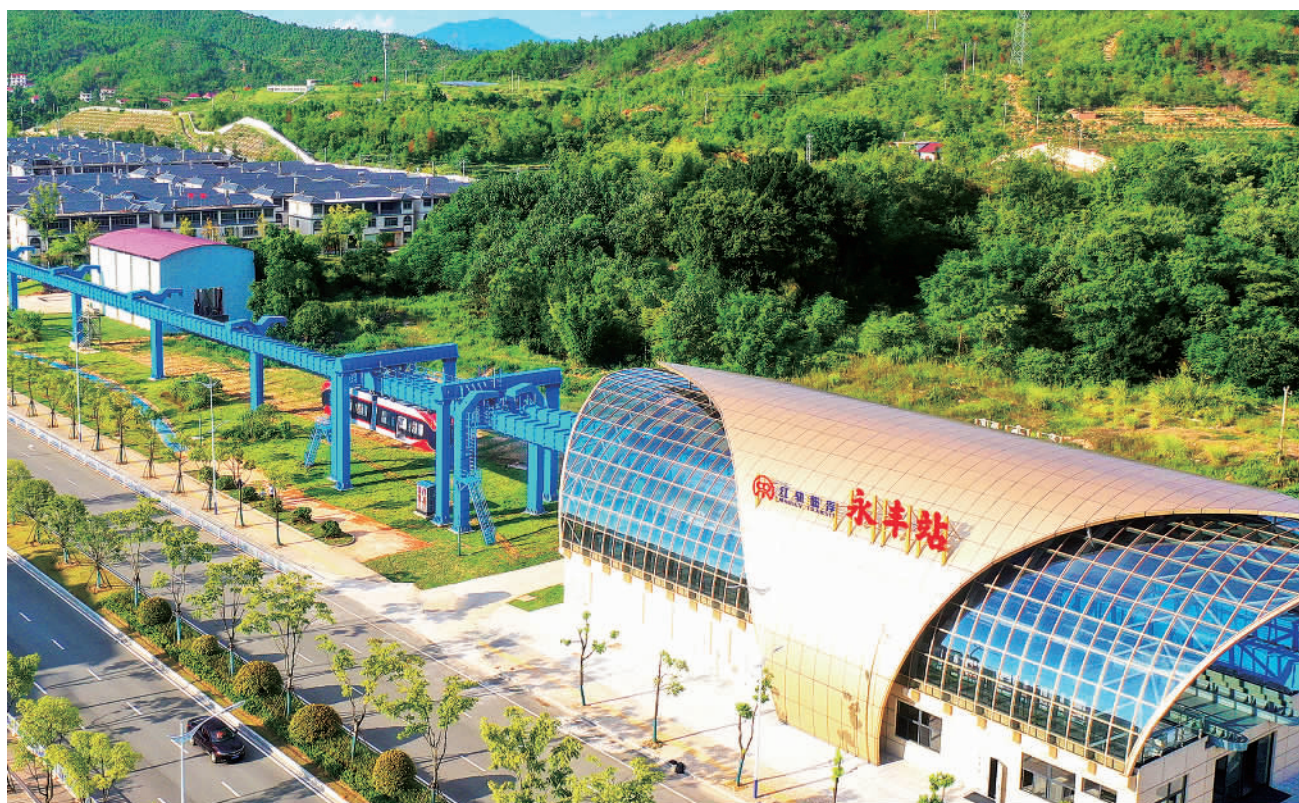
8月9日，国内首条稀土永磁磁浮轨道交通工程试验线——“红轨”在江西兴国县正式竣工，实现将稀土永磁磁浮技术与空轨技术结合，建成中低速、中低运量的新制式轨道交通系统。“红轨”最高设计运行速度为每小时80公里，不仅适用于城市、景区、机场接驳、商务中心环境，在沿江、环湖、海边、高寒、荒漠等也能使用，将助力绿色交通与低碳出行。熊红梅摄(中经视觉)
