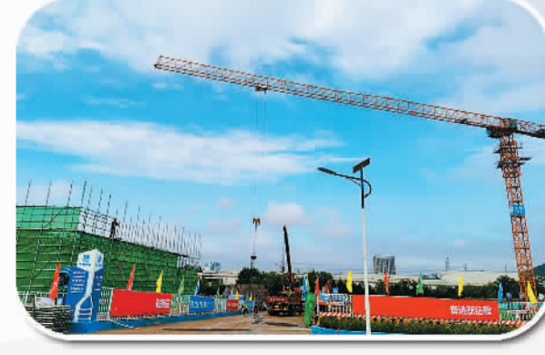
青岛虚拟现实产业园建设中
