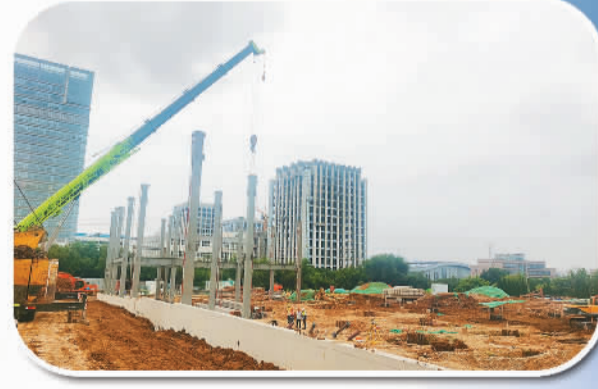
青岛虚拟现实产业园建设中
