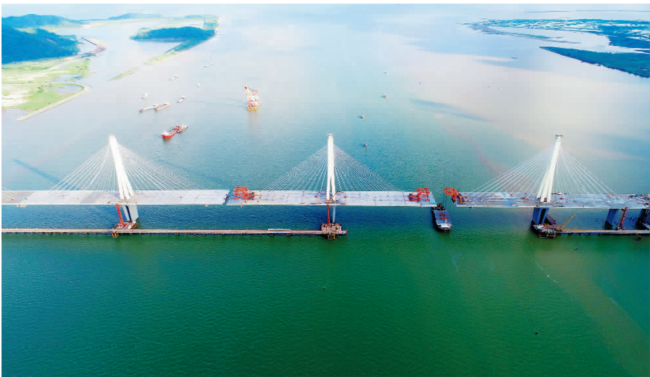
8月16日,广东珠海珠机城际金海特大桥建设现场。当日,大桥标准钢箱梁全部架设完毕,预计8月底合龙。金海特大桥是珠机城际二期关键控制性工程,对促进粤港澳大湾区交通基础设施协同发展具有重要意义。孟庆龙摄(中经视觉)
