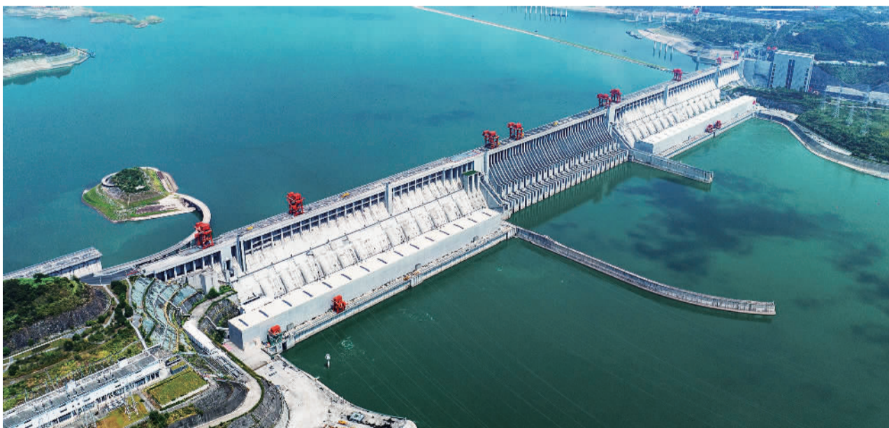
8月17日,湖北省宜昌市,正在为下游补水的三峡大坝。水利部长江水利委员会16日发布调度令,调度三峡水库于当日12时起向长江中下游补水。
