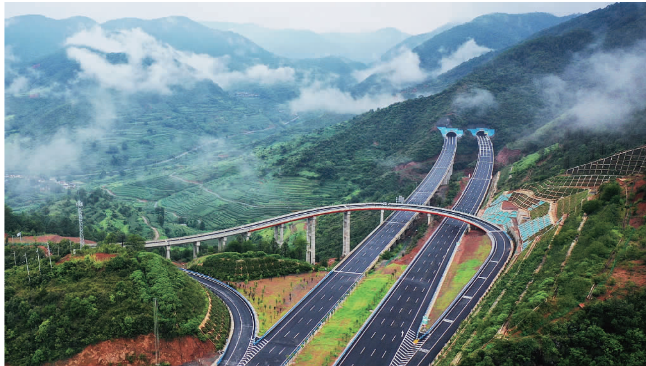
8月26日,云南玉(溪)楚(雄)高速公路全线通车,两地通行时间将由原来的近4小时缩短为1.5小时。玉楚高速的建成通车串起了玉溪、昆明、楚雄3州市7区县,对完善滇中路网、推动滇中地区发展具有重要意义。邓建伟摄(中经视觉)
