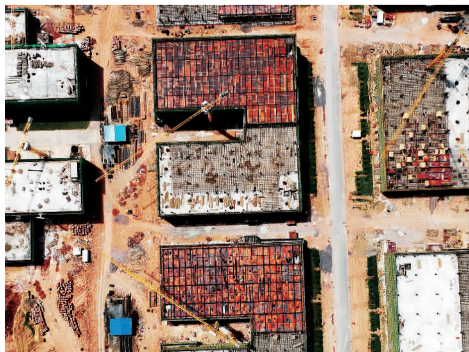
8月25日,江西省鹰潭市高新区智能化标准厂房(一期)建设项目正在加紧建设。当地克服疫情等不利因素影响,推进智能化标准化配套设施建设,推动重大项目加快落地,保障产业项目早落地早开工早见效。 曾志凡摄(中经视觉)
