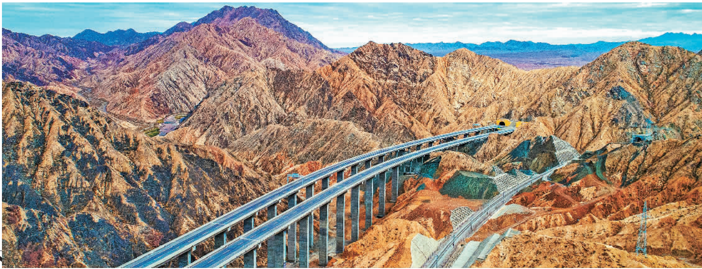
8月30日,由中国交建投资建设、中交二航局参建的新疆若羌县依吞布拉克镇至若羌县城公路正式通车运营。依若公路的建成,意味着进出疆第三条大通道贯通,对打造新疆“一带一路”“新丝绸之路经济带”核心区,建设中巴经济走廊带,促进新疆地区经济发展具有重要意义。新杰摄(中经视觉)
