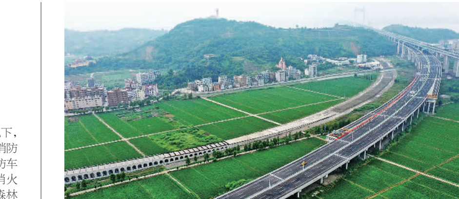
8月31日,沿海公路228国道浙江乐清乐成至黄华段通车。228国道是我国最长的沿海公路,起始辽宁丹东,终止广西东兴。乐成至黄华段主线采用双向六车道一级公路标准。蔡宽元摄(中经视觉)
