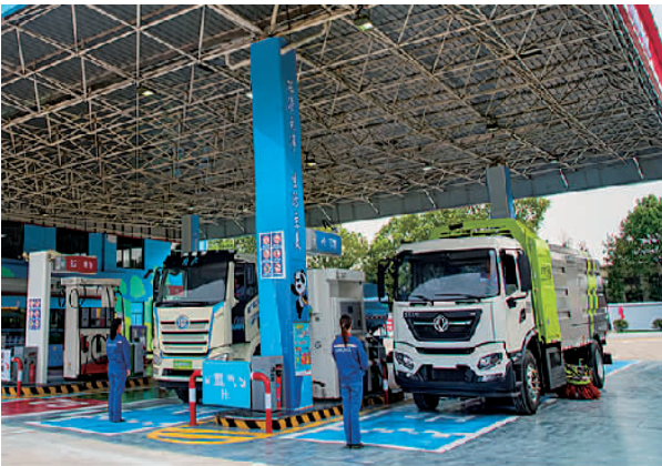
上海首座35兆帕/70兆帕加注能力油氢合建站落成。(资料图片)
