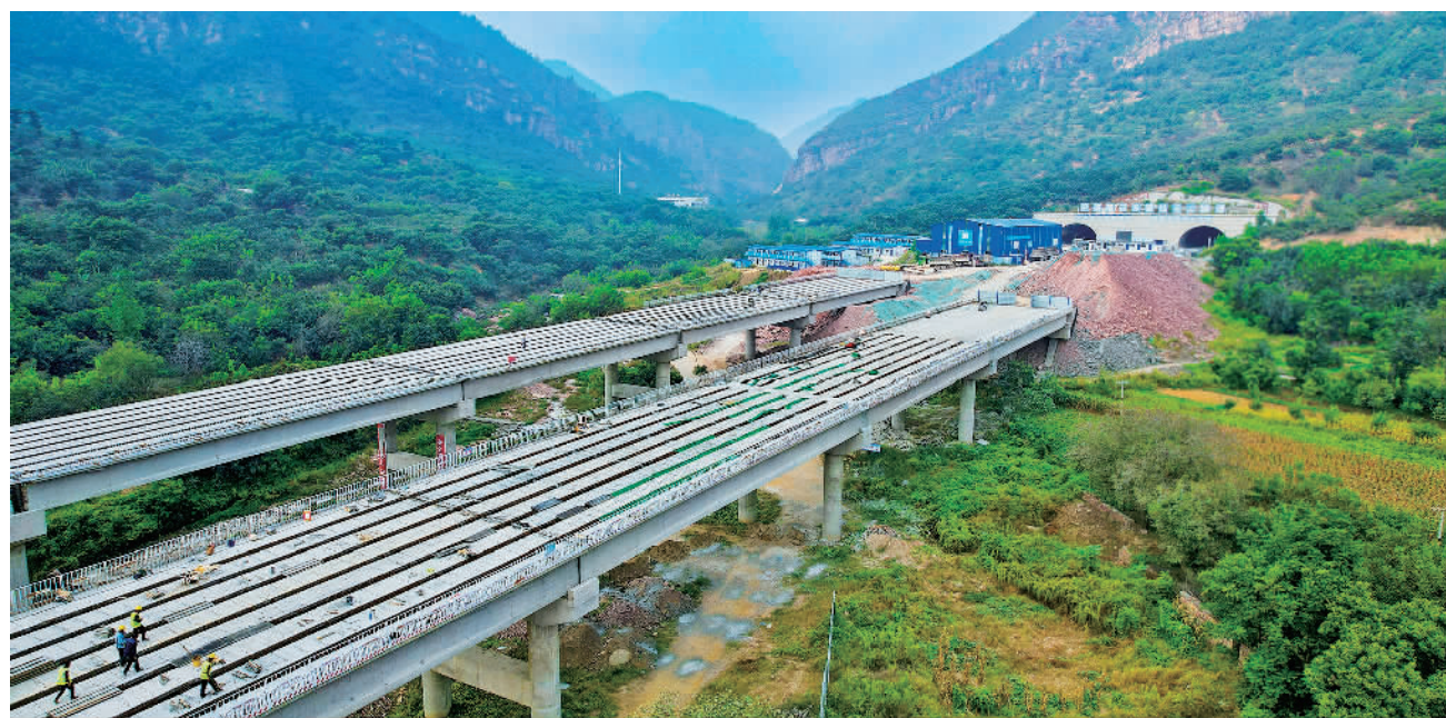
9月13日,位于河北省迁安市的京秦高速公路(遵秦段)全线第二长隧道贯通。京秦高速是京津冀协同发展交通一体化重要组成部分,通车后将缓解京哈高速交通压力,对京津冀协同发展乃至东北振兴具有重要意义。 张子亮摄(中经视觉)
