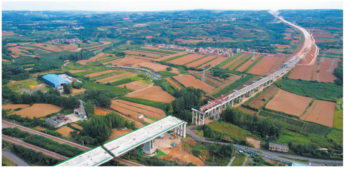
9月21日，由中铁十六局集团参建的河南淅浙高速公路淅池至洛宁段控制性工程——淅池大桥上跨陇海铁路连续刚构桥提前3个月安全顺利转体。淅浙高速公路淅池至洛宁段全长40.152公里，建成后将为豫西地区再添一条交通大动脉，促进沿线地区经济发展。 许鹏摄(中经视觉)
