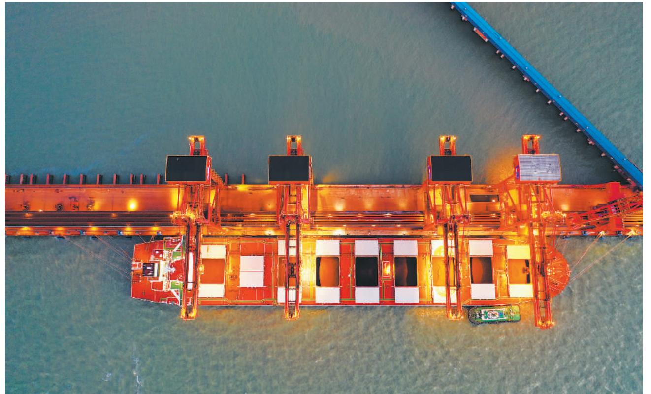
9月20日，浙江省宁波舟山港穿山港区中宅矿石码头，装载着17.8万吨澳大利亚铁矿砂的“宏梅”轮在忙碌作业，这是宁波市最大也是该市唯一一座30万吨级矿石码头正式投产后迎来的第一艘船舶。蒋晓东摄(中经视觉)
