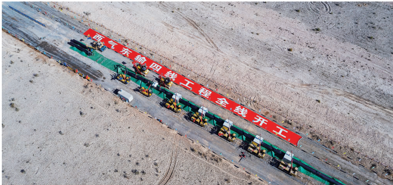
9月28日拍摄的西气东输四线工程开工现场。当日,国家管网集团西气东输四线工程正式开工。工程建成后,将进一步提升我国西北能源战略通道,提高我国天然气管网系统的管输能力。新华社发(国家石油天然气管网集团有限公司供图)
