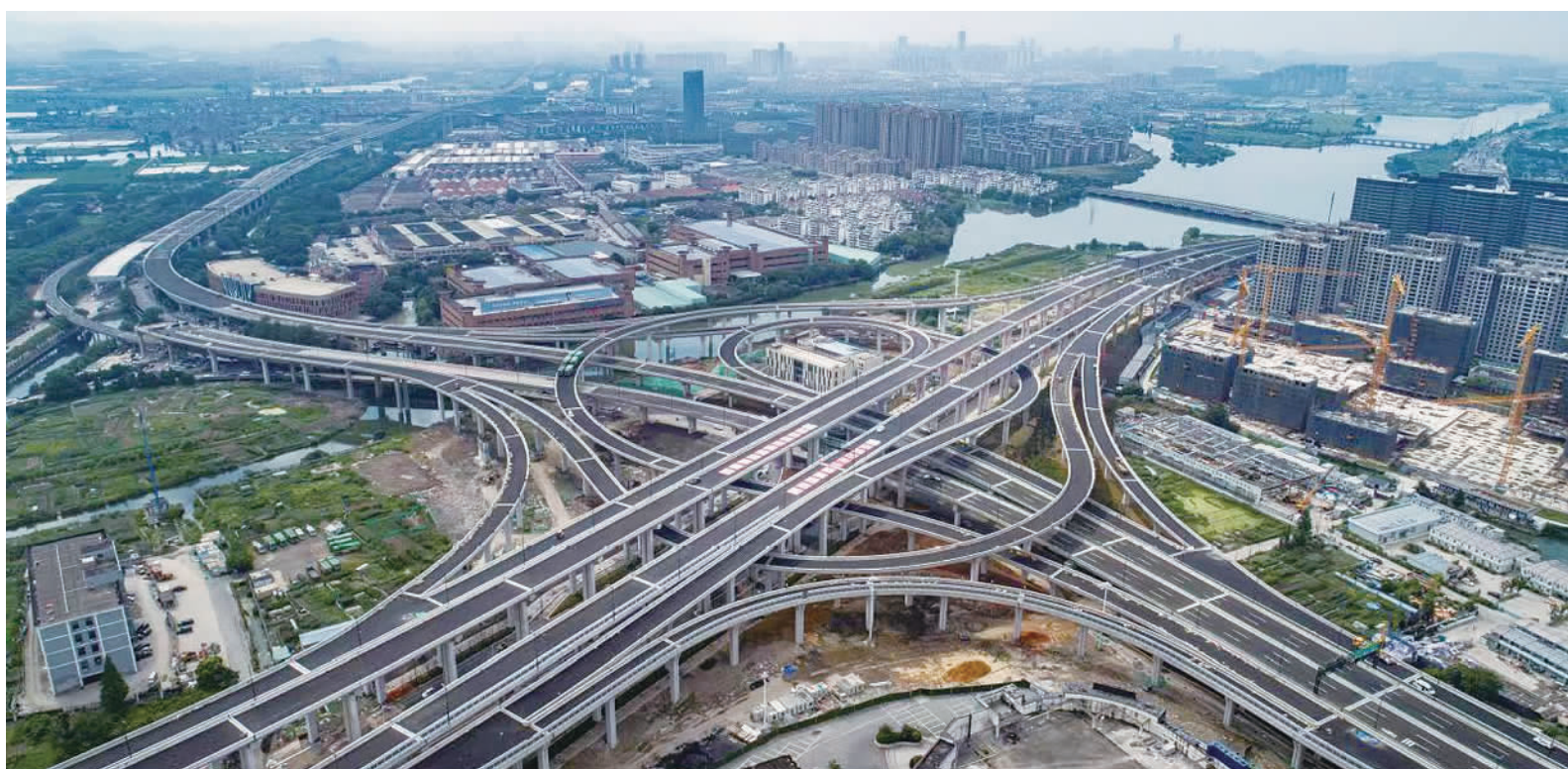
9月30日,杭州亚运会绍兴分会场重点配套工程——绍兴二环西路智慧快速路一期工程(山会大道—城南大道段)建成通车。该项目由浙江绍兴城投集团负责建设,中铁二十二局承建,是国内率先采用全预制拼装技术的城市高架。 刘慧琳摄(中经视觉)
