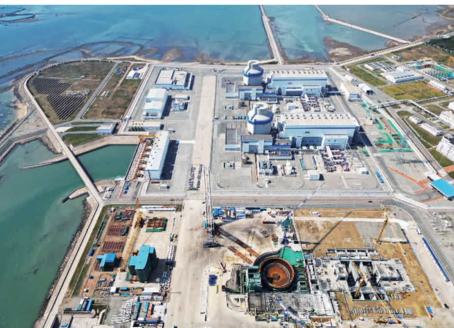
10月7日，山东海阳核电站3号机组施工正忙，目前3号机组核岛安全壳封顶模块已吊装就位。该核电站3号、4号机组采用我国三代非能动核电技术，单机容量1253兆瓦，年发电量约200亿千瓦时，计划于2027年全面建成投产。唐克摄(中经视觉)
