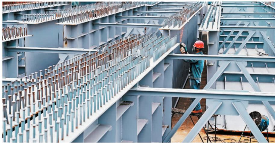
江西新钢联天结构科技有限公司是一家以生产免涂装耐候钢结构桥梁和高端冷弯型钢为主的装配式建筑企业。近年来,该公司加大设备升级改造力度,通过全套计算机集成控制实现标准化设计、工业化生产等,既提升了桥梁建设质量,又大幅缩短了建造周期。图为工人在车间加工钢结构桥梁。
