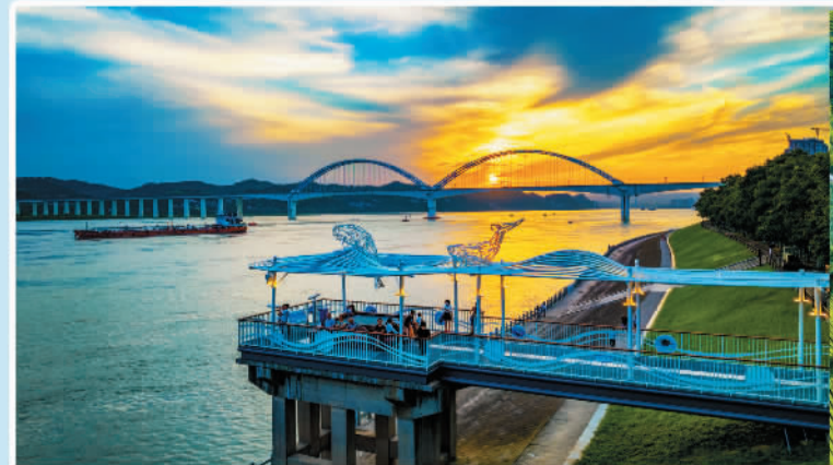
随着长江岸线治理和码头整治的持续推进,湖北省宜昌市2021年关停并拆除了运营63年的王家河码头,保留平台结构,改造成江豚观测平台,昔日的老旧码头如今成了网红打卡地。图为市民在江豚观测平台欣赏江景
