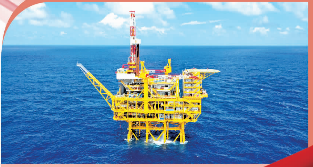
10月3日,深水导管架平台“海基一号”在南海陆丰油田作业区正式投产,平台高度和重量均刷新我国海上单体石油生产平台纪录。 新华社记者 梁旭摄
